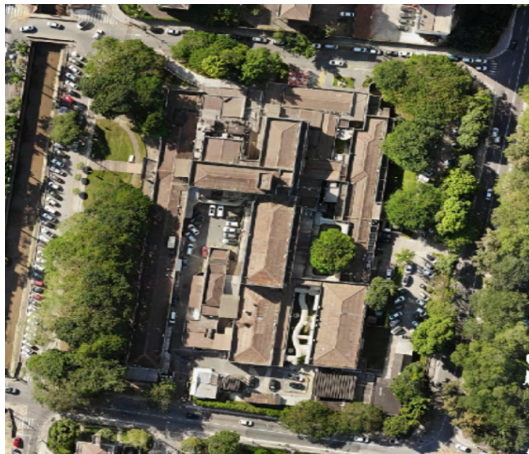
Figura 1: Visão Geral das Instalações do Hospital. Fonte. Autores, 2024
