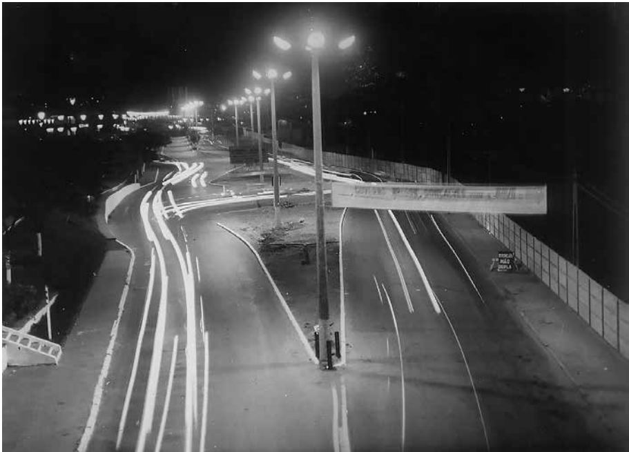
Asfaltamento e iluminação da Via Sérgio Braga.
