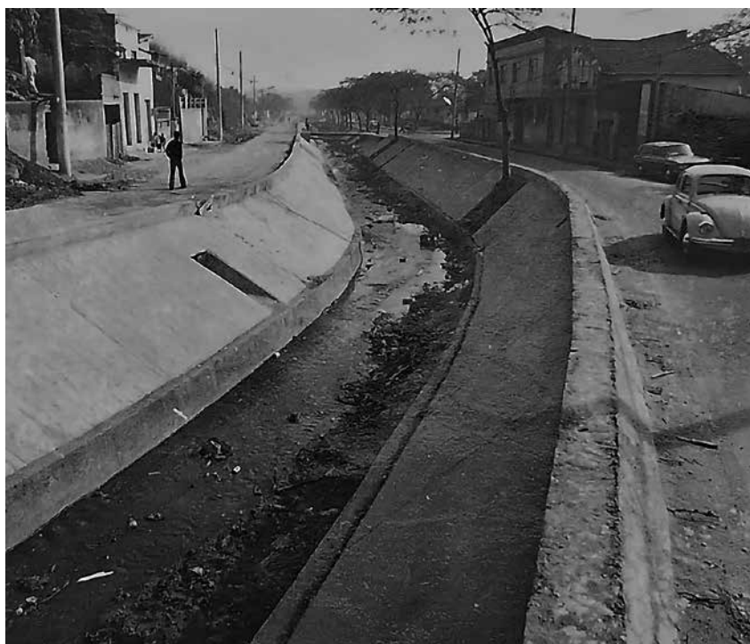
Canalização do Córrego Secades, no bairro 207.
