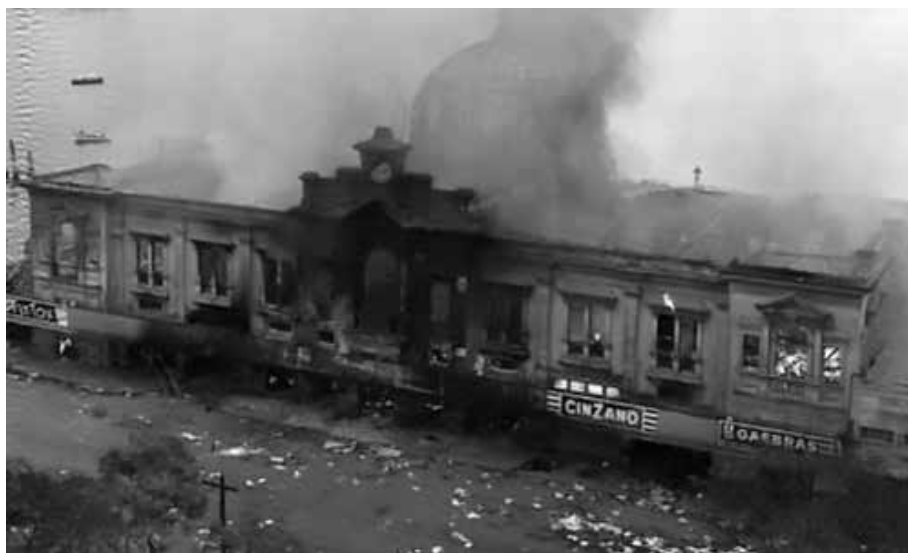
Estação das Barcas de Niterói, no dia do quebra-quebra.
