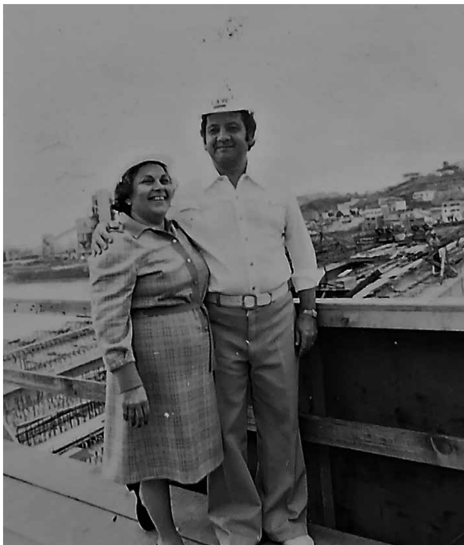
Nelson Gonçalves e sua esposa, Gecy Gonçalves, visitam a obra do Elevado Castelo Branco.
