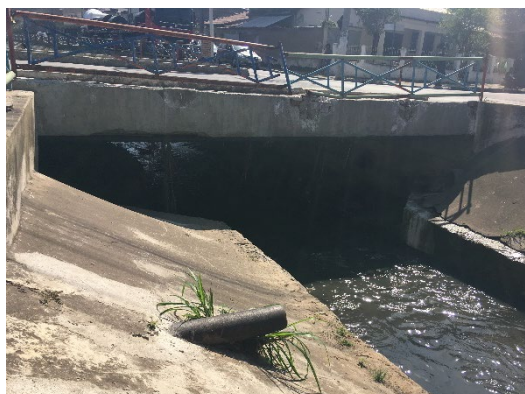
Figura 5 – Redução brusca de seção sob a Avenida Nossa Senhora da Conceição.
