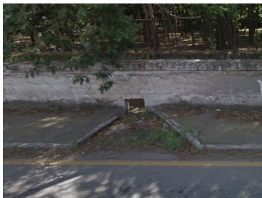
Figura 4 – Abertura no canal para água pluvial.
