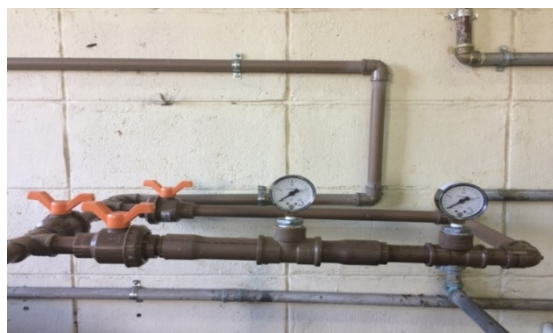
(Figura 7 – Tubo de Venturi Antigo)
