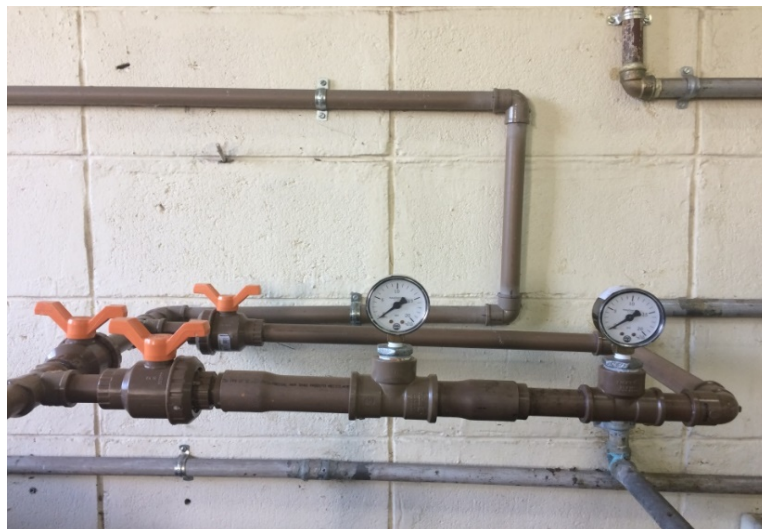
Figura 6 - Tubo de Venturi
