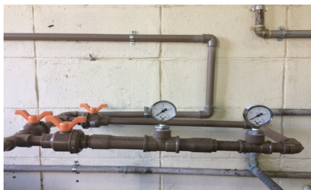
Figura 6- Tubo de Venturi
