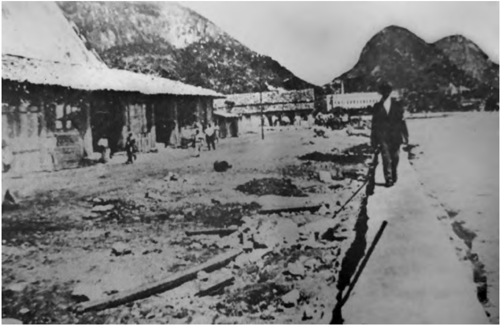
Obra do cais da Urca.
