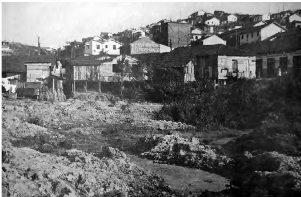
Um dos grandes problemas que Savio encontrou foi falta de saneamento básico. A foto é do bairro Eucaliptal antes das obras.
