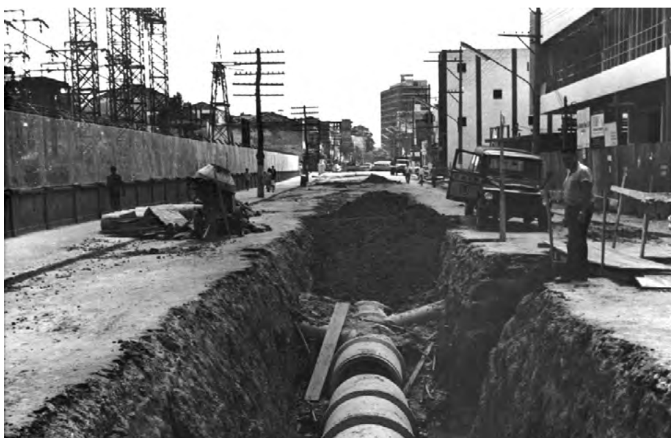
Obras na Avenida Amaral Peixoto.
