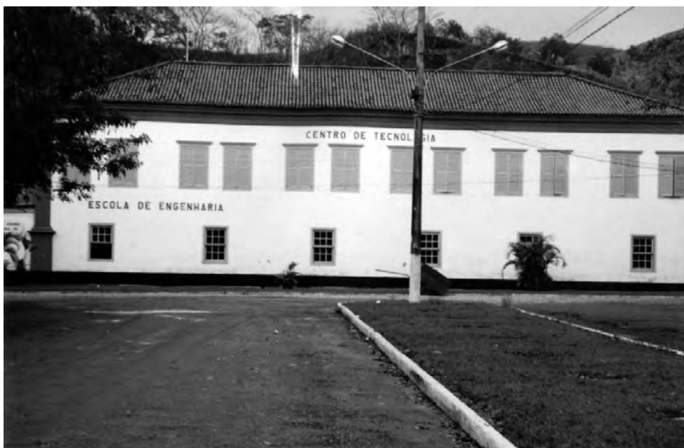
Vista lateral da Escola de Engenharia Civil na mesma ocasião.
