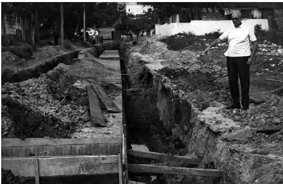
Savio diante das obras de canalização.
