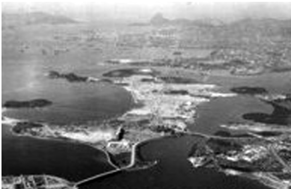
Construção e aterro da Cidade Universitária, Rio de Janeiro.
