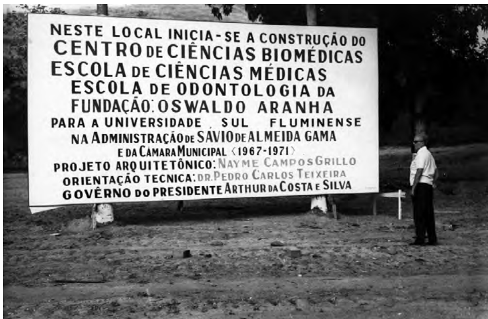
Savio diante da placa que marca o início das obras da escola de Ciências Médicas da FOA.
