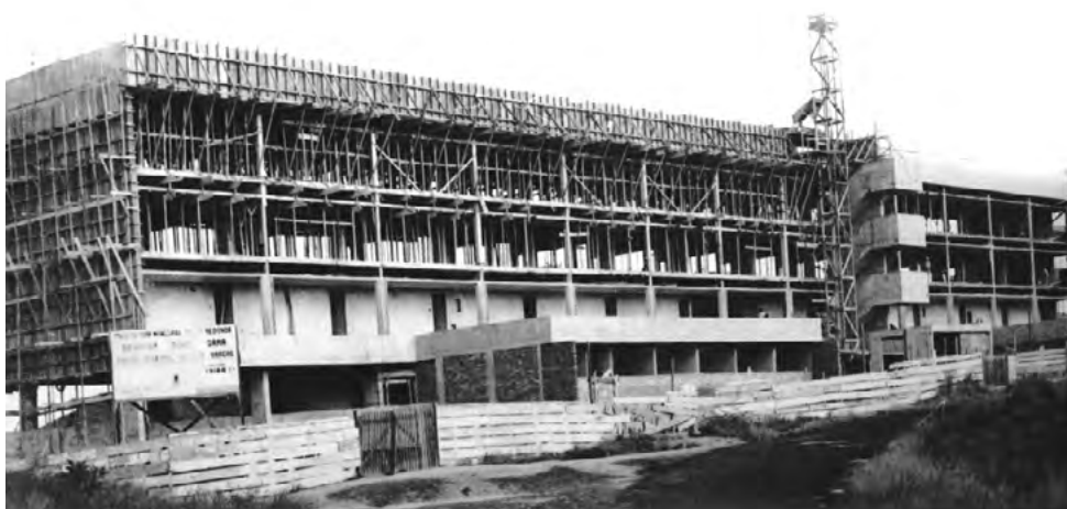
Getúlio Vargas em construção, em 1969.
