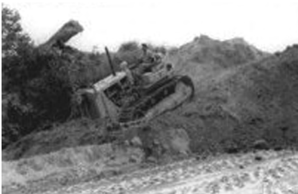
Fase de construção e aterro da Cidade Universitária.
