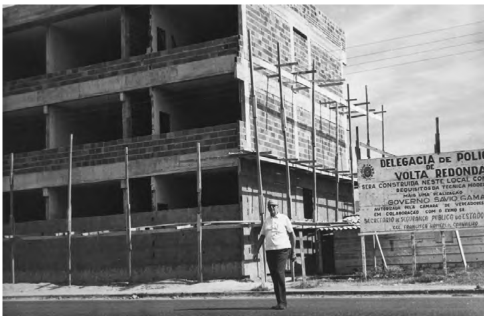
Savio Gama inspeciona as obras da futura Delegacia de Volta Redonda.
