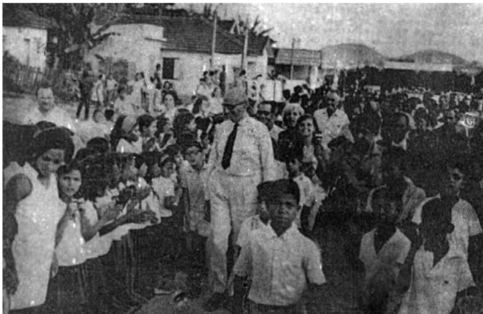
Inauguração da canalização do Córrego dos Coqueiros.
