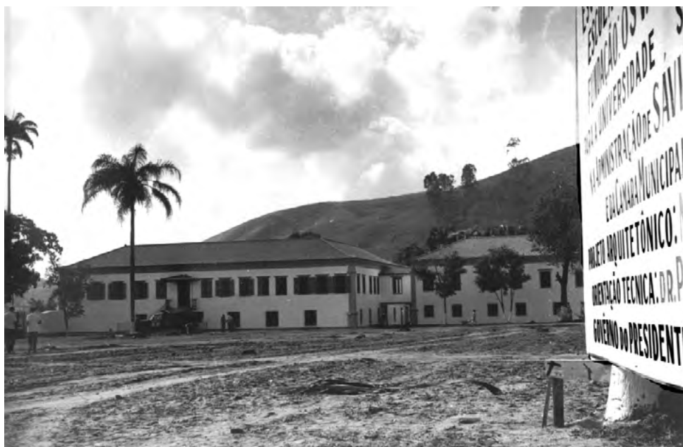
O canteiro de obras da Escola de Ciências Médicas da FOA e a Escola de Engenharia ao fundo.
