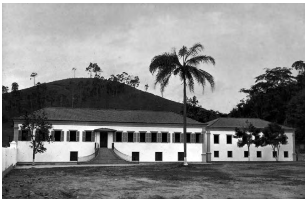
O prédio da Escola de Engenharia, logo após a sua restauração, inaugurado em 17 de julho de 1969.
