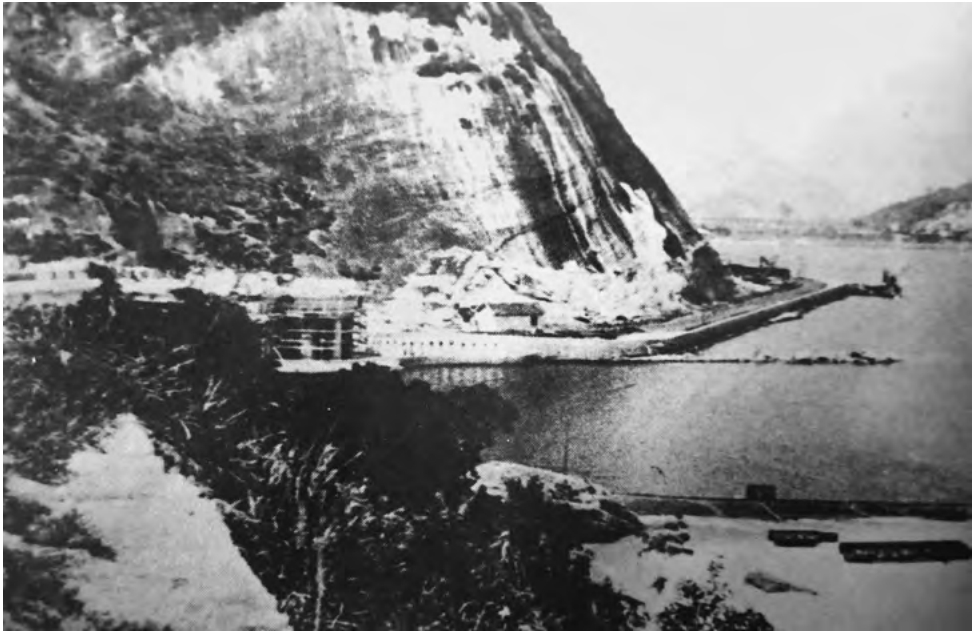
Vista panorâmica do Balneário da Urca em construção.
