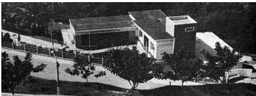
Estação de tratamento do SAAE- ETA.
